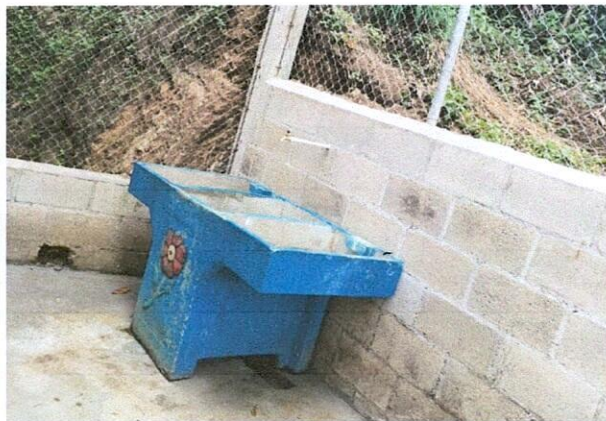
Foto 3: REPARACIÓN DE DRENAJE Y AGUA POTABLE
