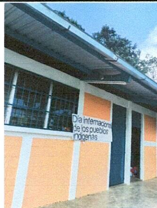
Foto 2: CANAL BAJADA DE AGUA PLUVIALES
